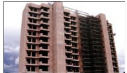
**BLOCO A** – O reboco das fachadas com os contramarcos será concluído em dezembro. Internamente, serão executados 50% dos pontos de nível (tariscamento) do reboco das paredes e do contrapiso.
